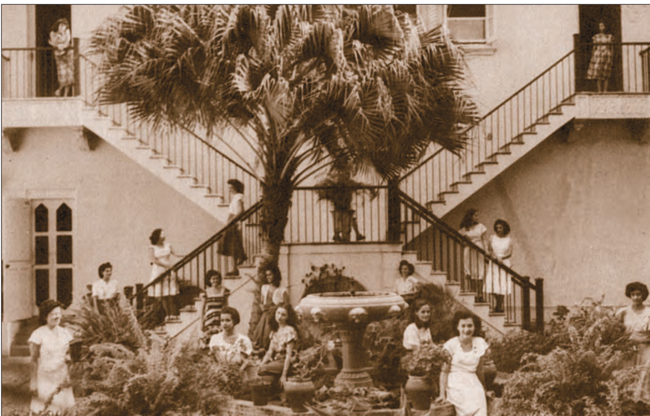
Patio interior Residencia de Señoritas Edificio Carlota Matienzo
