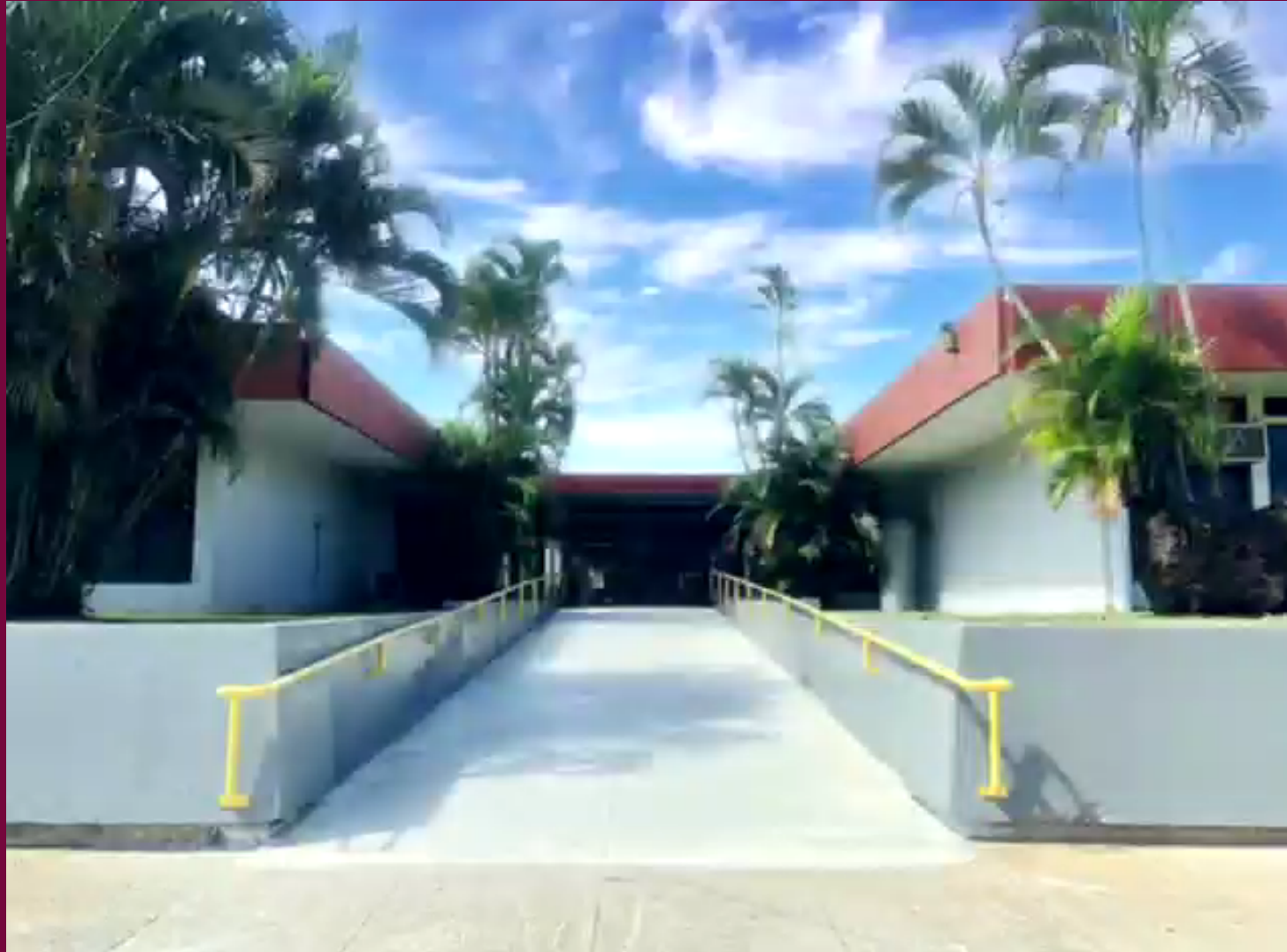
Nueva rampa de acceso en entrada principal
